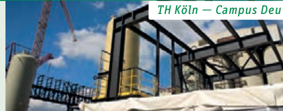
Stahlkonstruktionen im Bau | Fotos: © STABEL+HOHN GmbH
