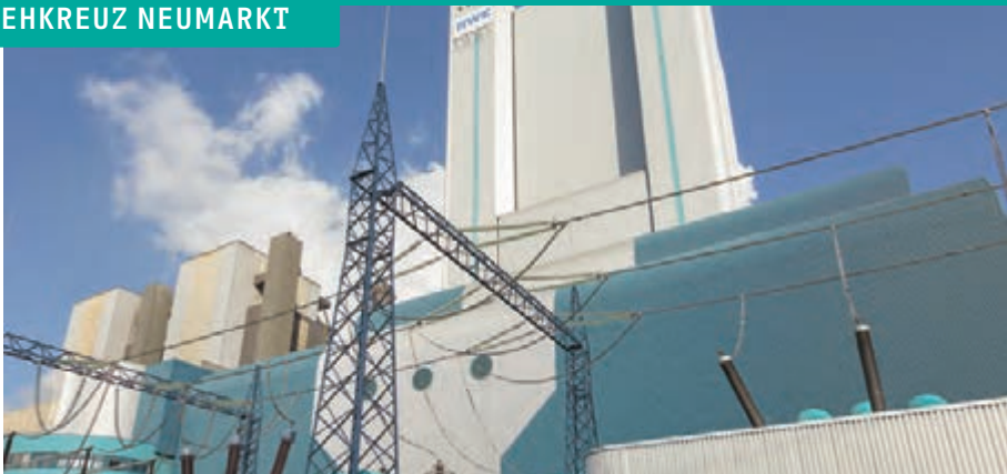
Diagonalsicht der beiden BoA-Blöcke am Standort Niederaußem | Fotos: © RWE Power
