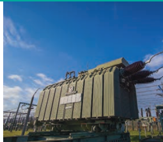
Leistungstransformator 110.000/11.000 Volt
