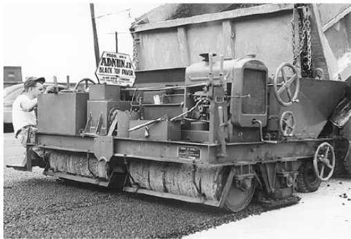
Straßenfertiger aus den 1950er-Jahren noch ohne schwimmende Bohle 1
