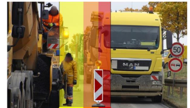
Beispiel: Arbeitsbereich an einer Baustelle
