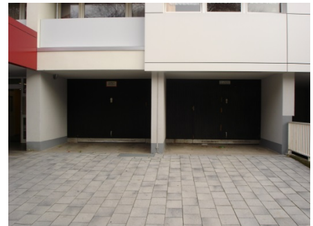
Abbildung 6: Zugang zu den Tiefgaragen, Görlinger Zentrum 3
